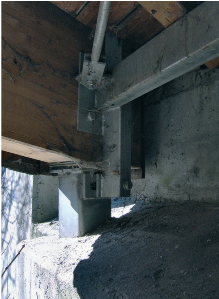
In pagina: due particolari della sagomatura delle spalle in c.a. libere da ogni residuo
