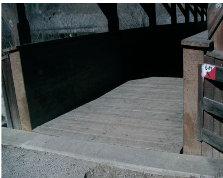
Dall'alto: particolare delle teste delle travi portanti non ricoperte da lamiera, copertura in scandole di Larice e perfetto stato conservativo dei correntini della copertura del ponte,
