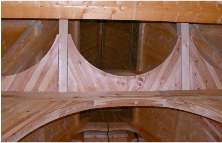
A pagina 56 metodo costruttivo stav (chiesa di Gol) In senso orario controventi di piano, mensola irrigidente con decori, mensole di irrigidimento del piano orizzontale, altro esempio di controventi di piano, elementi irrigidenti della chiesa a pianta basilicale di Heddal
